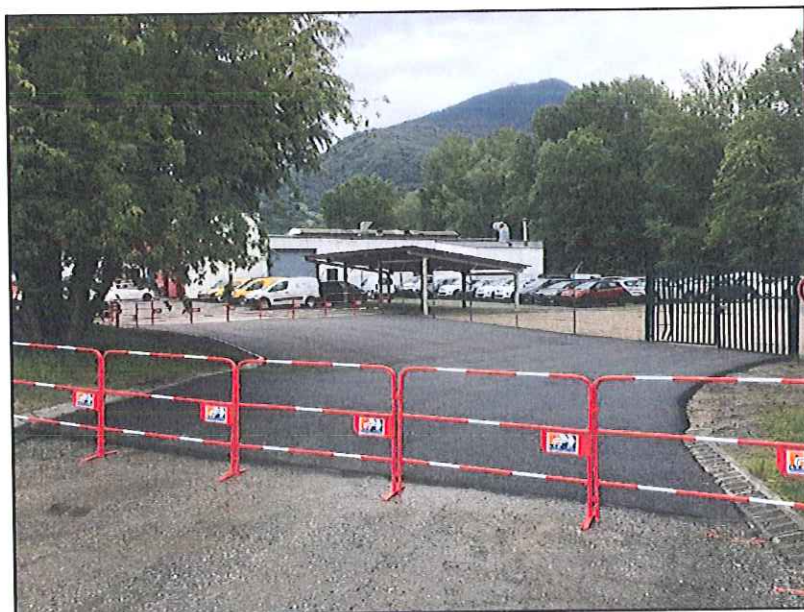
Vue de l'ancienne station-service AS24 (12/05/2017)
